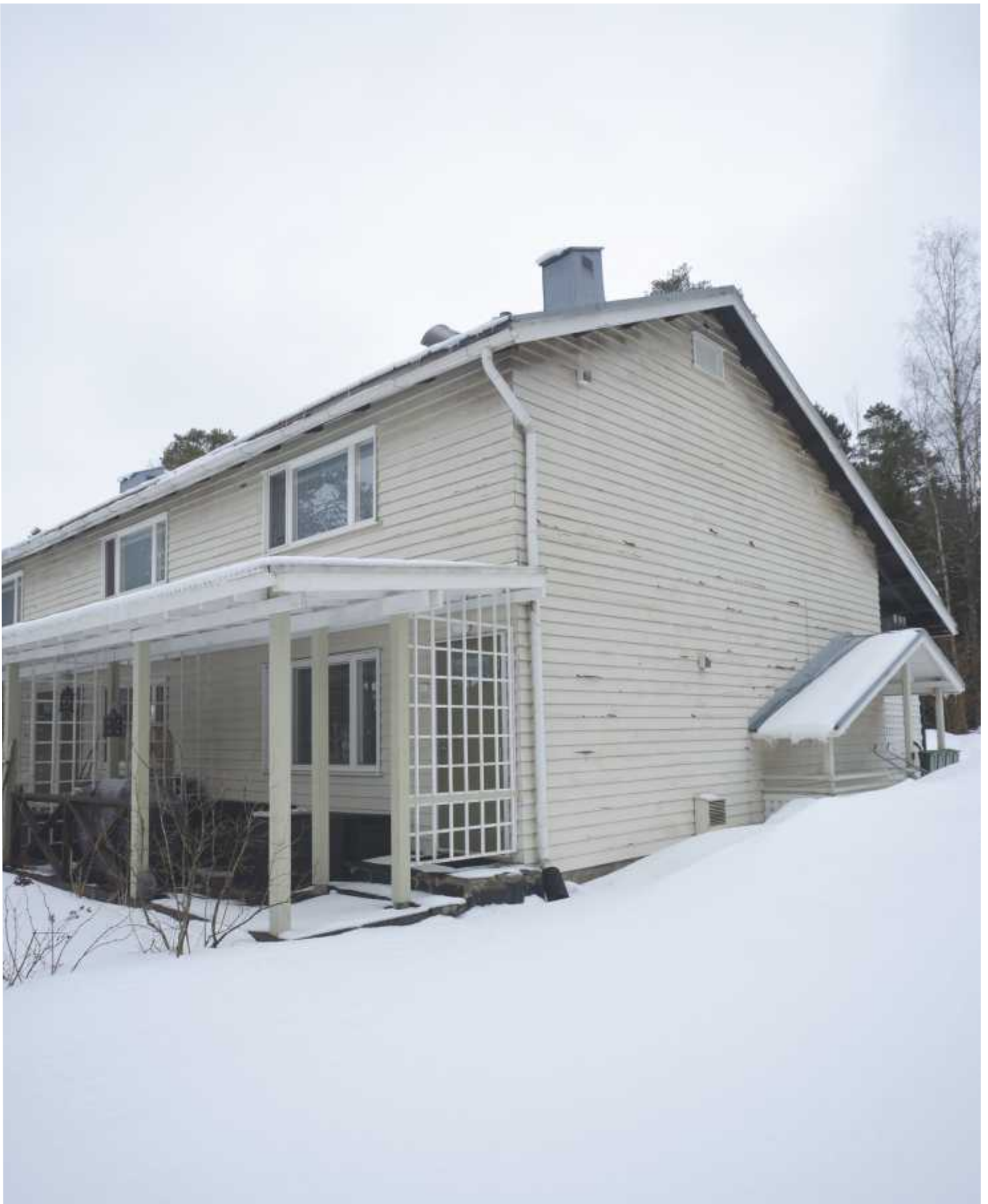
Alvar Aallon suunnittelema Aaltopuisto, entiseltä nimeltään Neekerikylä, on rakennettu vuosina 1944 – 1947 Strömbergin työntekijöiden asuinalueeksi. Rivitaloja rakennettiin yhteensä 15. Neekerikylä-nimitys johtuu siitä, että rakennukset olivat alkujaan tummapintaisia.
