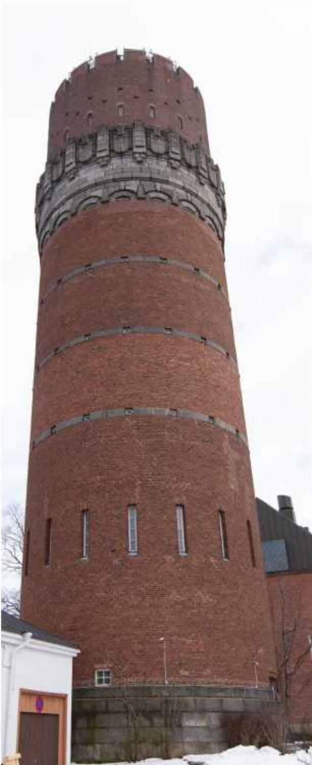
Vuonna 1915 rakennettu Vaasan vesitorni on Suomen vanhin toiminnassa oleva vesitorni.
