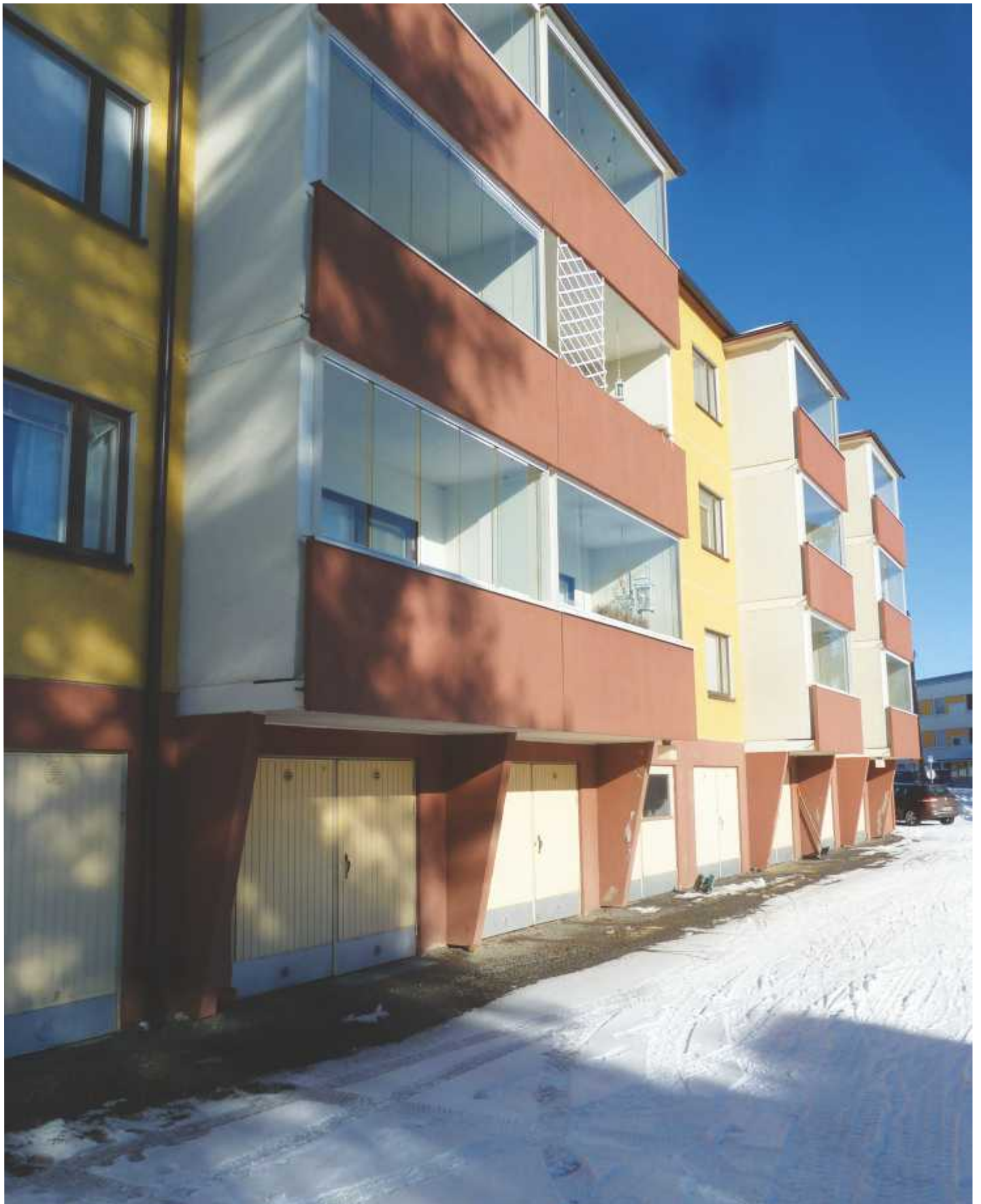
KE Nymanin rakennusliikkeen rakentama Asunto-osaakeyhtiö Palosaarentie 61 valmistui vuonna 1965. Se oli alkujaan aravatalo, joka muutettiin osaketaloksi 1970-luvun lopulla. Talossa on 24 asuntoa.
