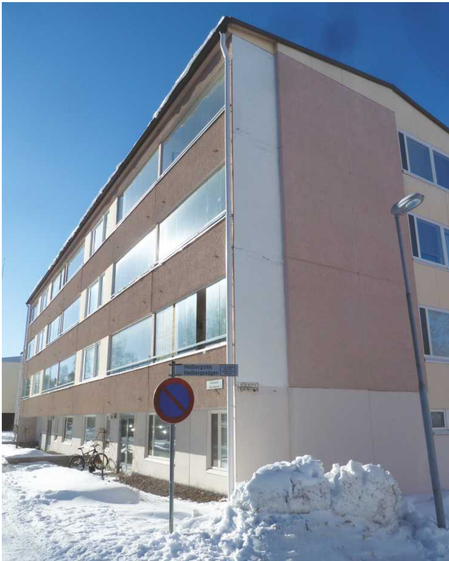
Vaasan Urheilukadun varrella olevassa Asunto Oy Vaasan Säästöportaassa on kaikkiaan 83 asuntoa ja kaksi liikehuoneistoa. Kiinteistö on valmistunut vuonna 1963.
