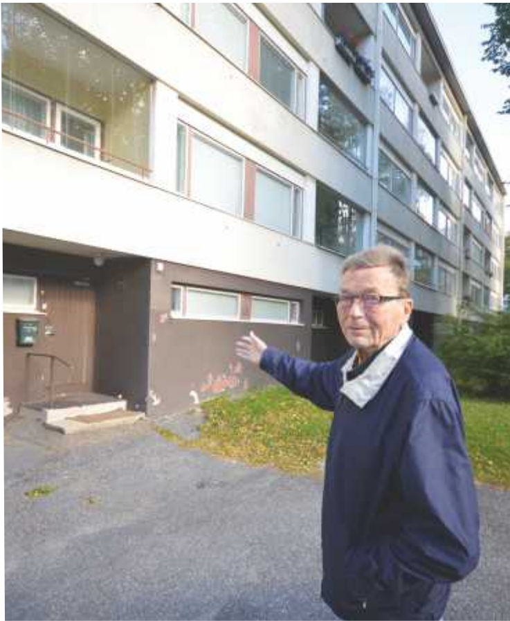
Roger Mattbäck osoittaa Koulukatu 43:n pohjakerroksen tiloja, joissa isännöintitoimisto Pohjanmaan Asuntokiinteistöjen Palvelu Oy toimi kymmenisen vuotta. Talo on Vaasan ensimmäisiä aravataloja.
